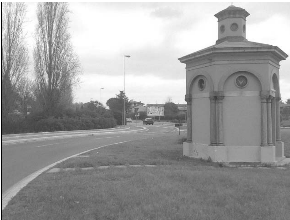
Via Cesenatico km 4+680 loc. Ponte Pietra dir. mare - Cim. 1
