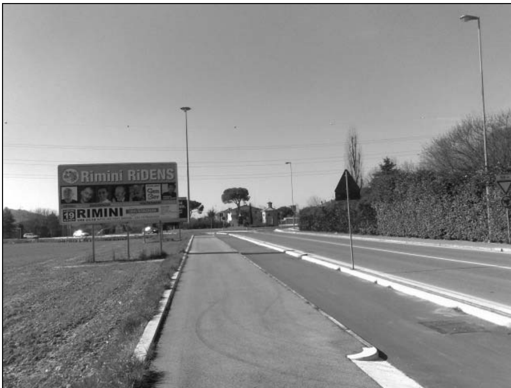
Via Cesenatico km 4+680 loc. Ponte Pietra dir. Cesena - Cim. 2
