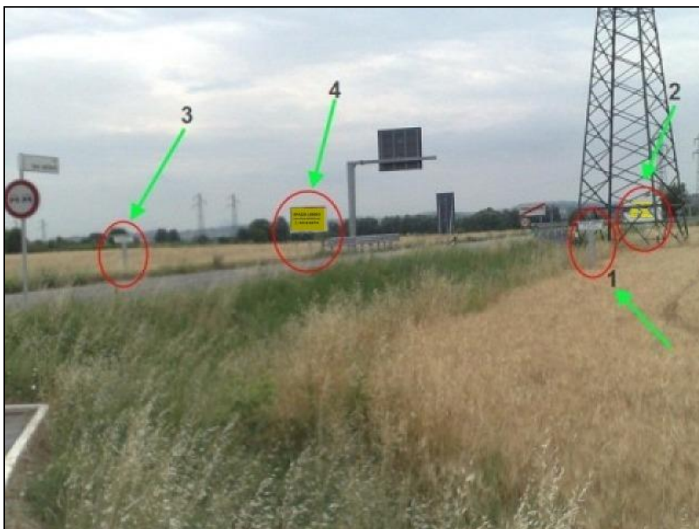
Via Leo Valiani loc. Ponte Pietra (Bretella Secante) - Foto panoramica degli impianti 1, 2, 3, 4
